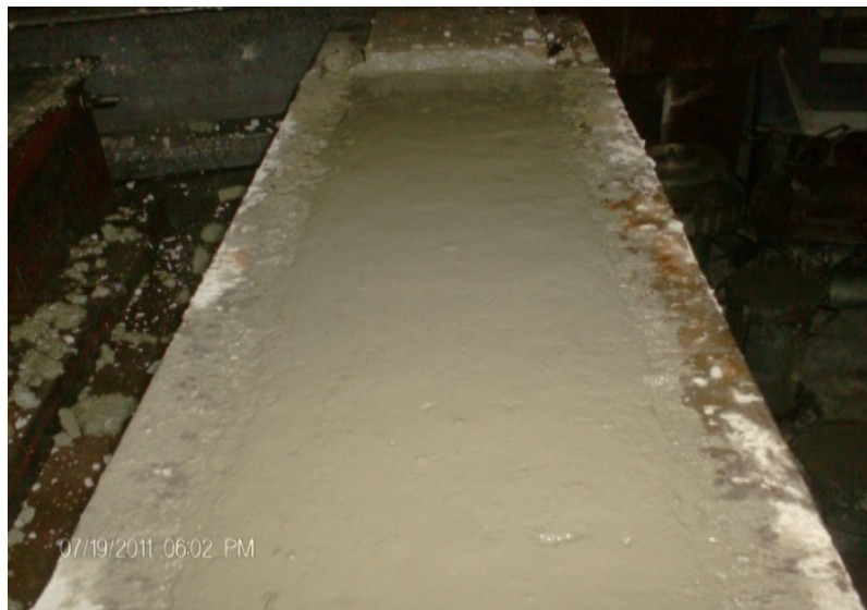
Figura 22. Vaciado de vigas en moldes metálicos
