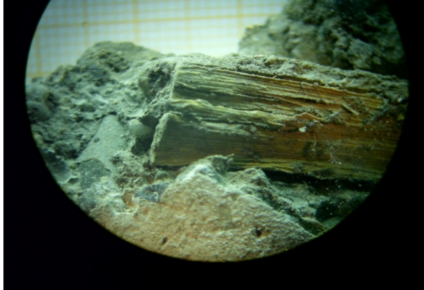
Figura 73. Mezclas de concreto reforzado con fibras de bagazo de caña presentando mala adherencia
