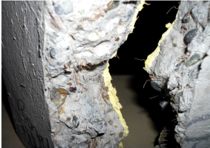
Figura 53. Fracturas de losas reforzadas con fibras de coco después de ensayada Fuente: Propia
