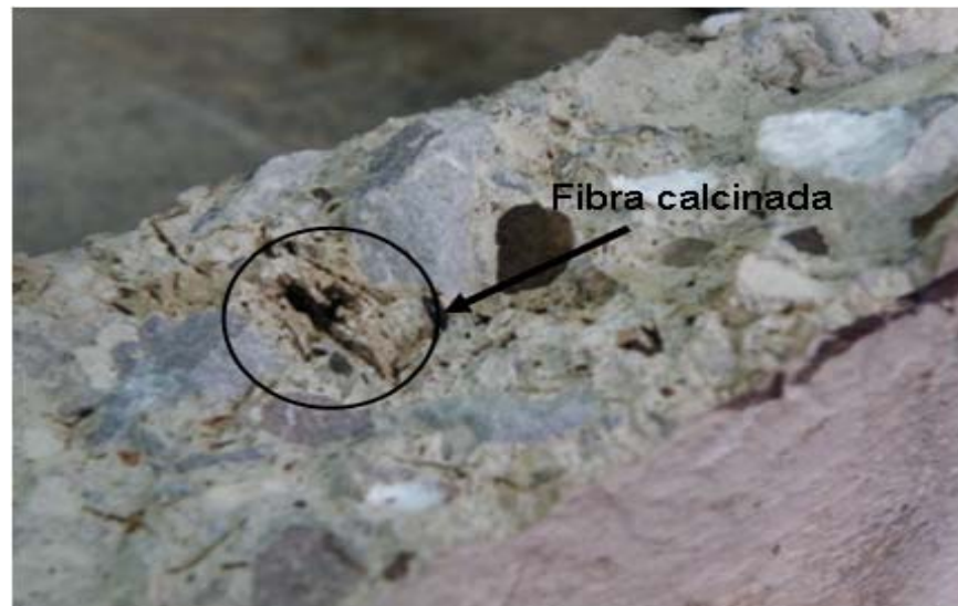
Figura 54. Losa con fibras de coco después de ser ensayada y expuesta a 600°C. Fuente: Propia
