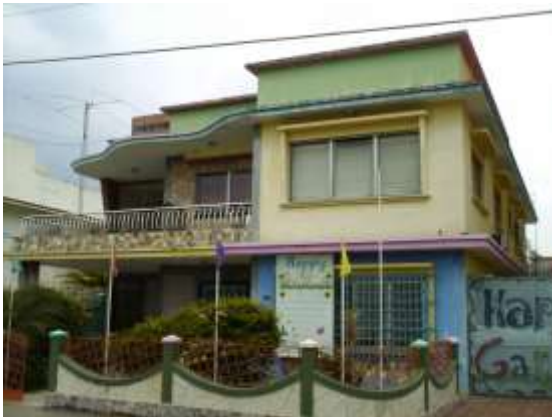
Urbanización El Viñedo, años 50. Arquitectura moderna.
