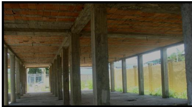
Figura 36. Vista de las vigas planas, losa de entrepiso.
