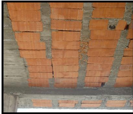
Figura 37. Vista de los nervios de losa.
