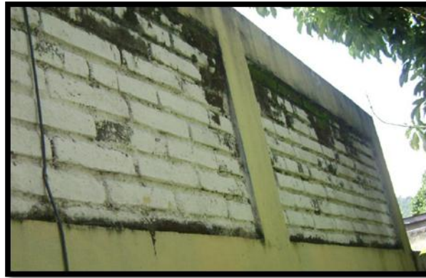
Figura 9. Pared afectada por cultivos biológicos. Nota: Tomado de Cisneros Marvin, Sorto William. (2008). (p 256).
