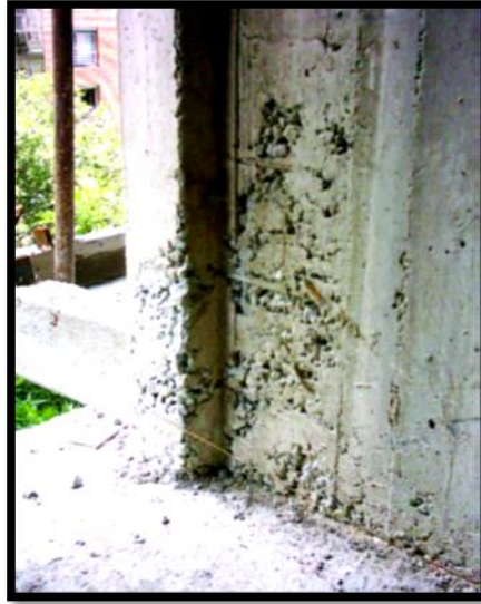
Figura 15. Ejemplo de mal vibrado de una columna. Nota: Tomado de A. Astorga, P. Rivero. (2009).
