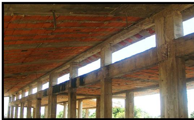
Figura 38. Vista de las columnas cortas.
