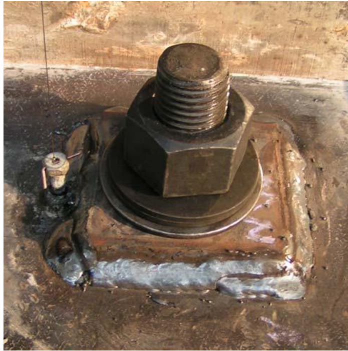
Figura 2.15 Fotografía de Barra con Arandela de Chapa Soldada.
