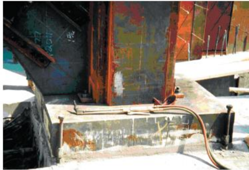
Figura 4.23 Placa Base con Tornillos de Ajuste.
