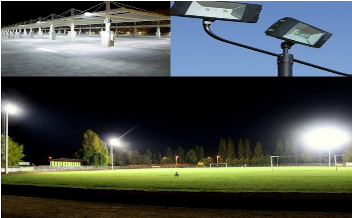
Figura 2.5- Iluminación de un estacionamiento, torre de reflectores y cancha de fútbol con LED.
