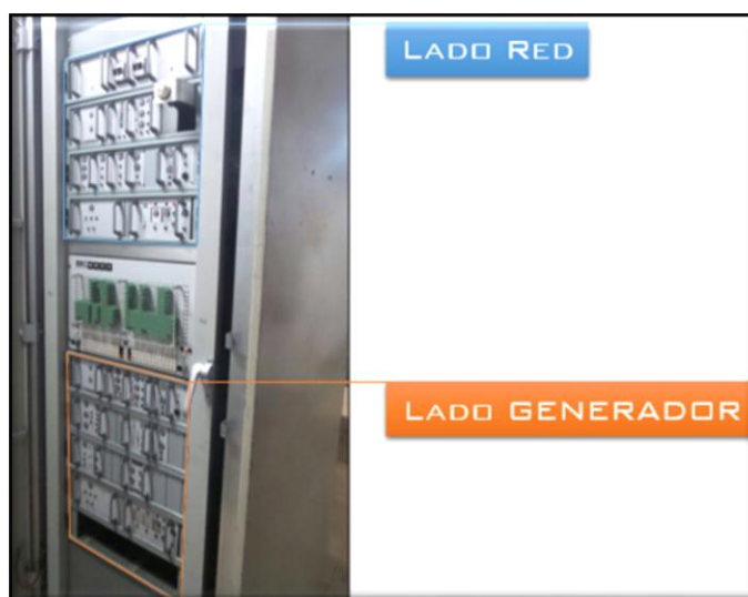
Figura 3.8 Unidad de protección GSX5 BBC Red-Generador. Fuente: Elaboración Propia.
