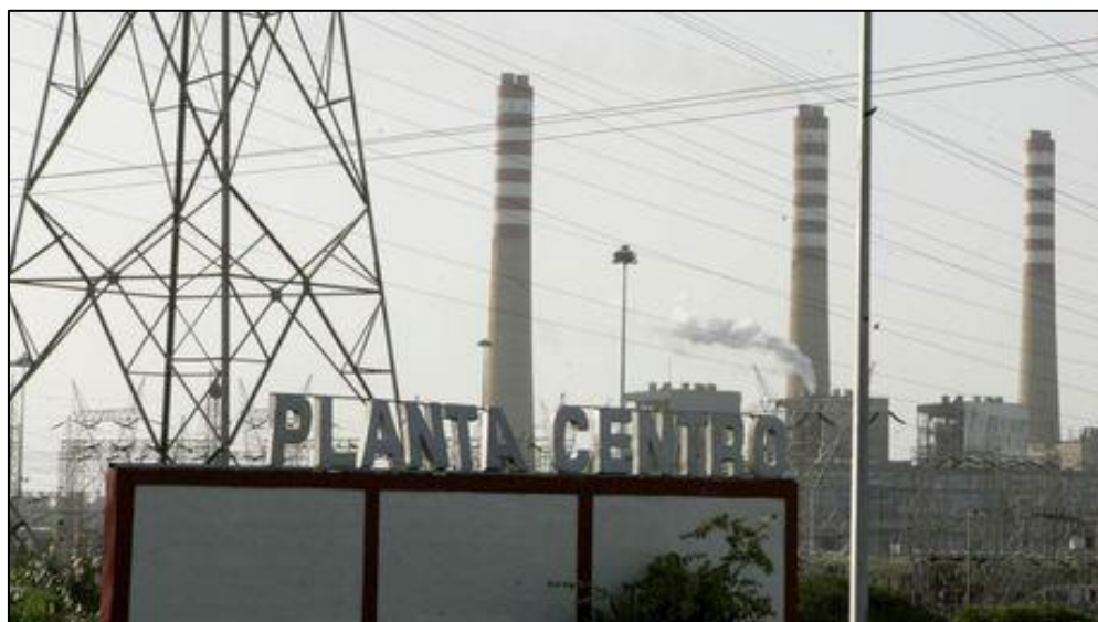
Figura 1.1 Entrada Principal de la Planta Termoeléctrica del Centro. Fuente: Romero T. Diario El Nacional/Archivo (2015).
