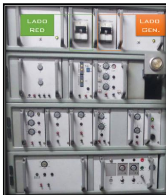
Figura 4.35 Interruptores de alimentación del GSX5. Fuente: Elaboración Propia
