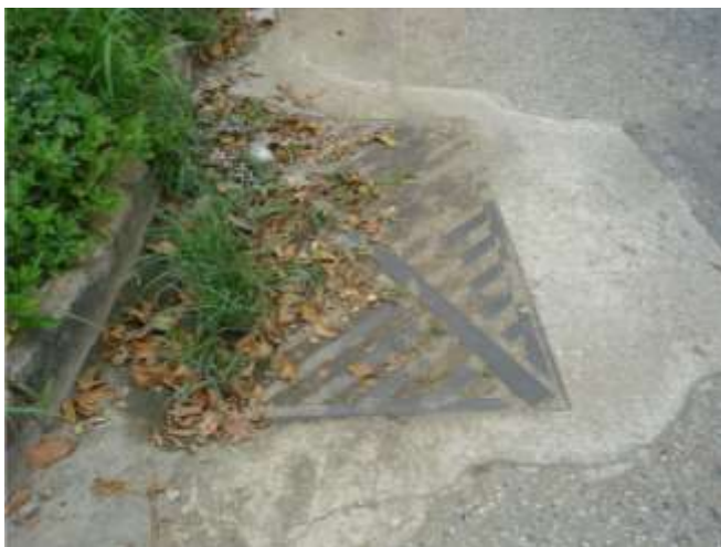
FOTO N° 4.- Vista de sumidero de rejas en la Av. 91, Urbanización Las Chimeneas.
