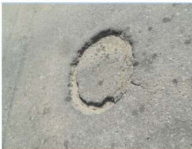
FOTO N° 3.- Vista de boca de visita ubicada en la Av. Cabriales, Urbanización La Trigaleña.
