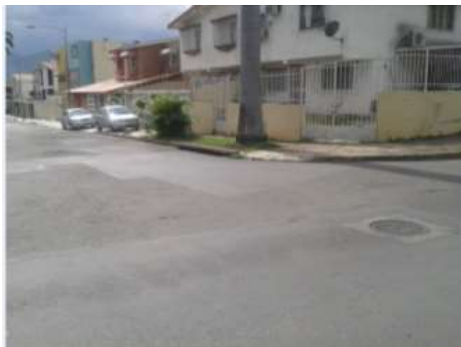
FOTO N° 1.- Vista de boca de visita ubicada en la Av. 90, Urbanización Parque Trigal.
