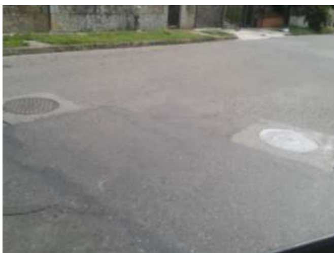
FOTO N° 2.- Vista de boca de visita ubicada en la Av. Cabriales, Urbanización Trigal Sur.
