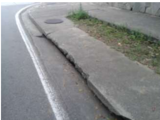
FOTO N° 6.- Vista de sumidero de ventana en la Av. Arturo Michelena, Urbanización La Parque trigal.
