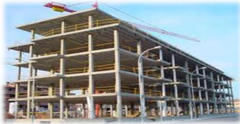
**Figura 4.** Estructura a base de pórticos de concreto armado.
