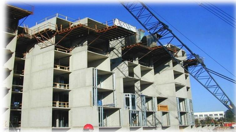
**Figura 5.** Construcción de Edificio tipo túnel.
