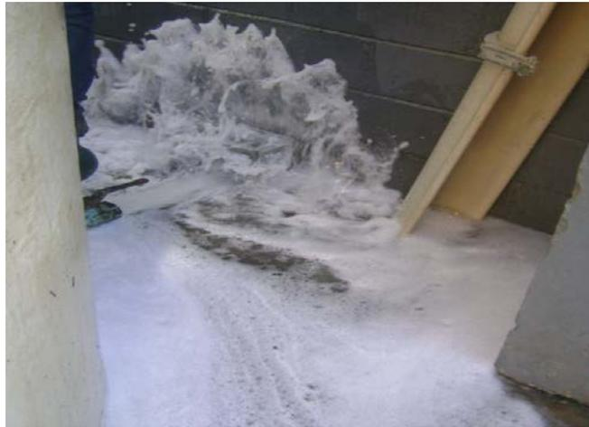
**Figura 5.4 Espuma en la purga del tanque de almacenamiento 2.**
