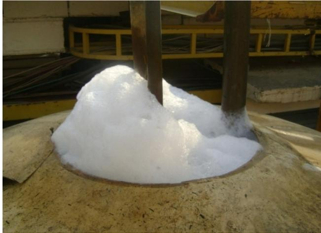
**Figura 5.3 Espuma desbordada en el tanque de almacenamiento 2.**
