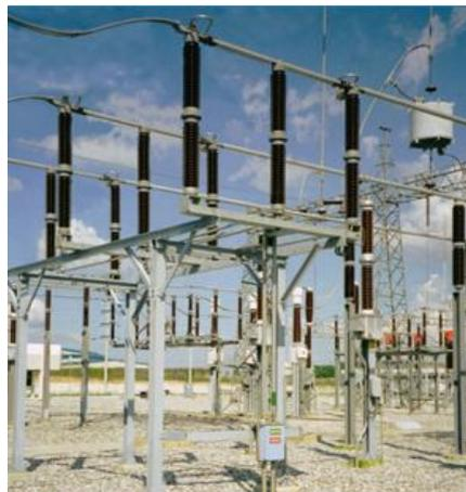
*Figura 13. Seccionador de una subestación*
