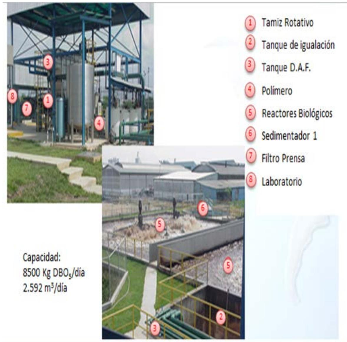
Figura 1.1. Planta de tratamiento de aguas residuales. Corporación Inlaca, C.A.
