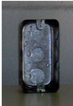
Figura 2.31.Caja Rectangular Fuente: Manual de Maestro Electricista INCE
