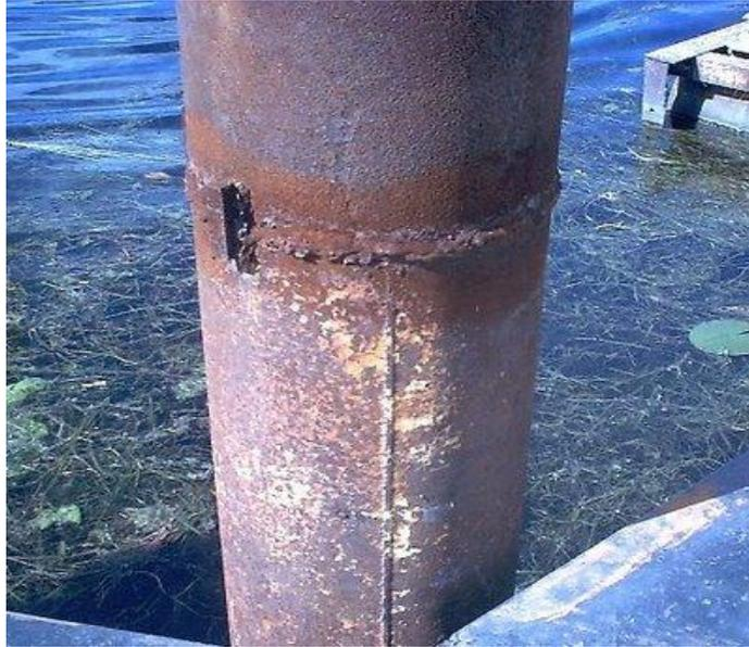
**Fig. 2.15. Corrosión salina. (Perry, 1998)**
