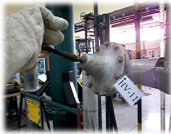
Figura 47. Válvula de diafragma HV-11
