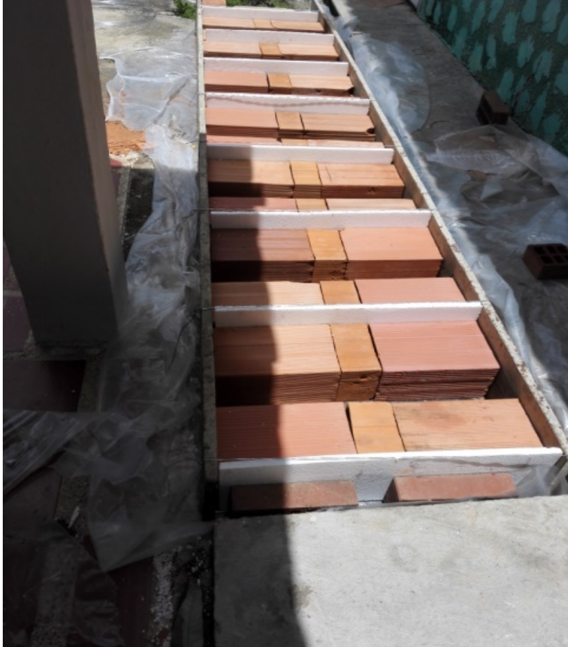
Figura N°9. Construcción de modelos de losas nervadas. (Bespín y Pérez, 2016)
