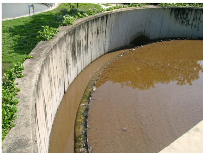
**Figura 4.8: Condición de operación del espesador de lodos antes de las modificaciones de carga y flujo de operación en la PTAR**
