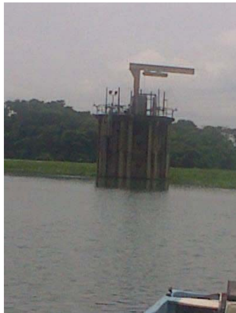
Figura 222: Torre – Toma del Embalse Pao – Cachinche.
