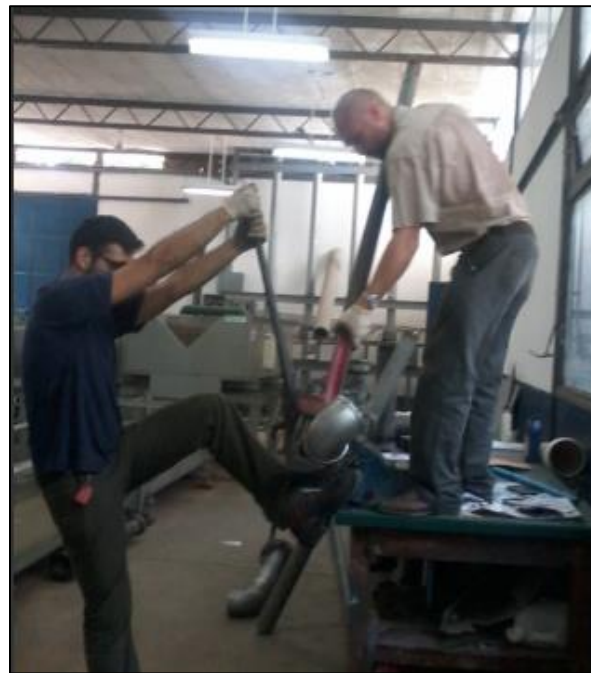
Figura 13. Ensamble del tramo principal de tubería del manifold en acero galvanizado del sistema de turbina Francis y turbina Pelton del Laboratorio de Hidráulica, Universidad de Carabobo.
