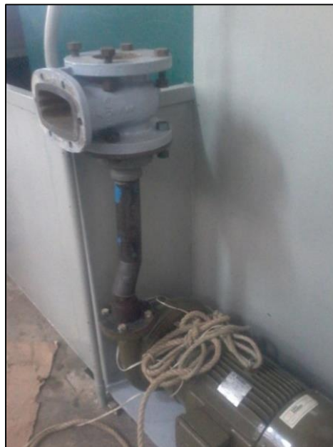
Figura 10. Instalación de la tubería de descarga de la bomba centrífuga del sistema de turbina Francis y turbina Pelton del Laboratorio de Hidráulica, Universidad de Carabobo.
