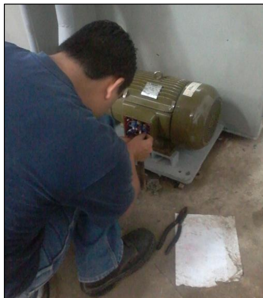
Figura 8. Instalación de la conexión eléctrica a la bomba centrífuga de distribución de caudal del sistema de turbina Francis y turbina Pelton del Laboratorio de Hidráulica, Universidad de Carabobo.
