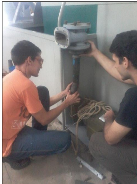
Figura 9. Pre ensamble de la tubería de descarga de la bomba centrífuga del sistema de turbina Francis y turbina Pelton del Laboratorio de Hidráulica, Universidad de Carabobo.
